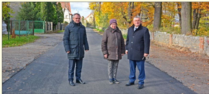
Fachowość i organizacja, współpraca z wykonawcą oraz cierpliwość mieszkańców Bartoszówka pozwoliły na ukończenie budowy bez większych problemów.
