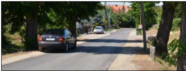
Odbiór wyremontowanej drogi odbył się 30 lipca br. Wartość wykonanych prac wyniosła 265 tys. zł.
