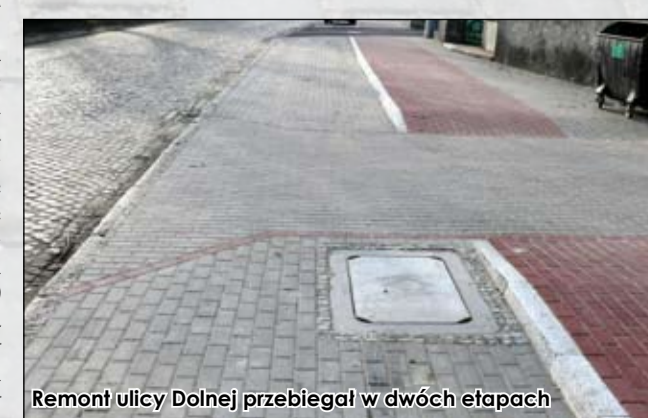
Remont ulicy Dolnej przebiegał w dwóch etapach
