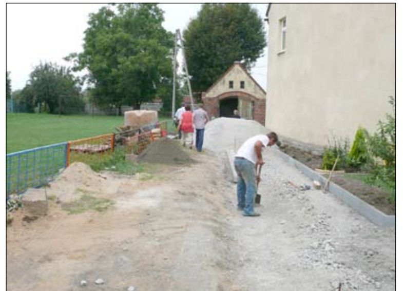
Nowo chodnik przy szkole w Stanowicach był potrzebny już od dawna
