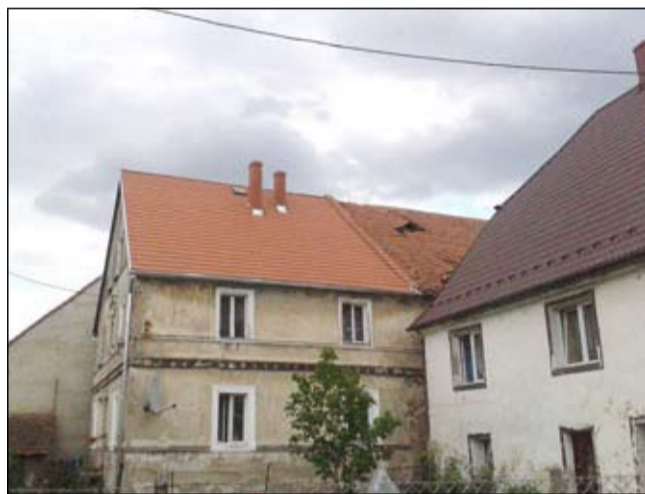
Dach budynku przy ulicy Brzegowej 55 w Strzegomiu zyskał nową dachówkę
